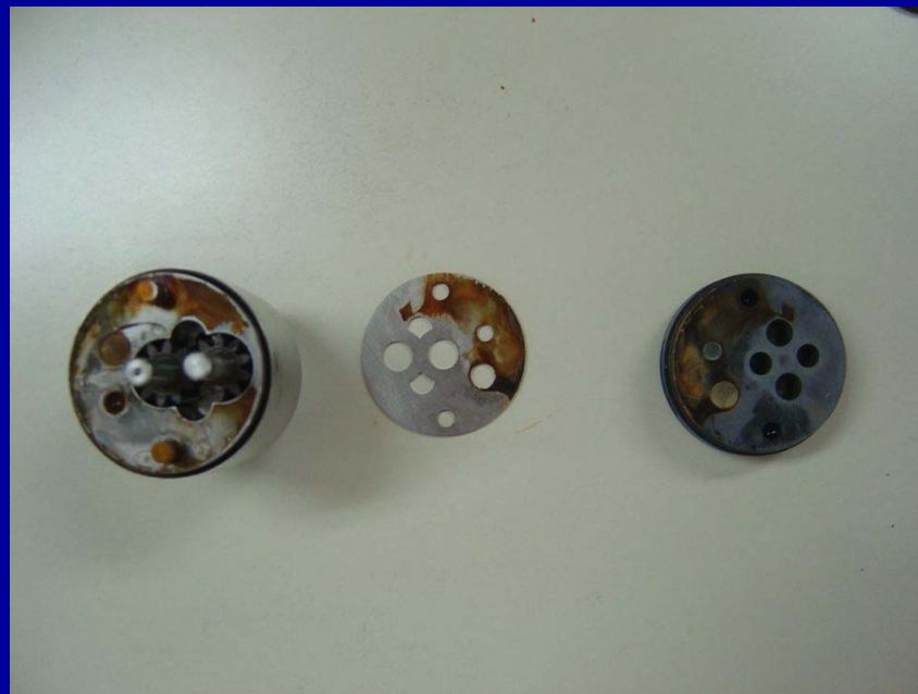
脱気ポンプ ポンプヘッドの錆
